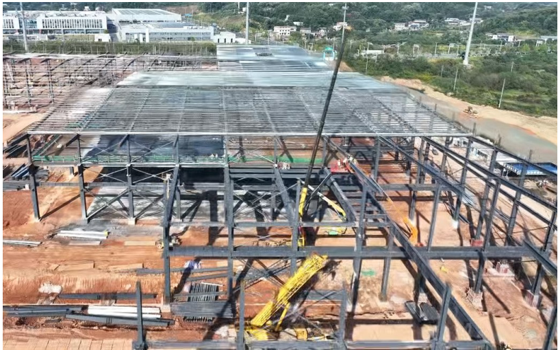
10月17日,石峰区清水塘新能源装备产业新城,中交(长沙)建设有限公司承建的双碳产业园二期项目建设正酣。通讯员供图
