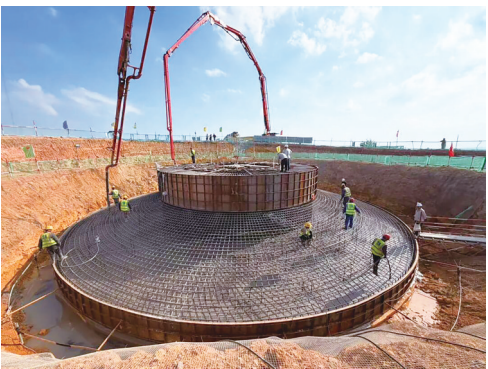
该项目施工现场。企业 提供
