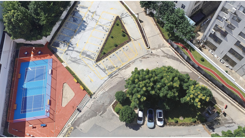
大岭社区闲置地块微改造。通讯员 供图
