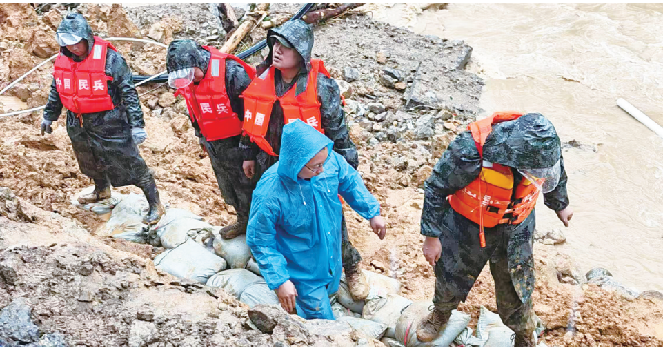
▲沔渡镇村干部冒雨加固垮塌河堤。刘瑾波 供图
