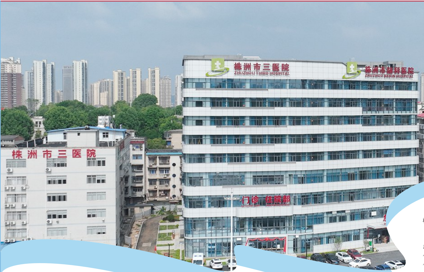
株洲市三医院(株洲市脑科医院)新门急诊综合楼全貌
