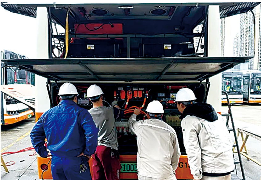
中车电动智源团队工程师们正在调试设备。 通讯员 供图
