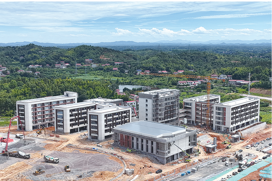
湖南师范大学附属涪口普通高级中学项目建设现场。通讯员/曾俊敏 摄
