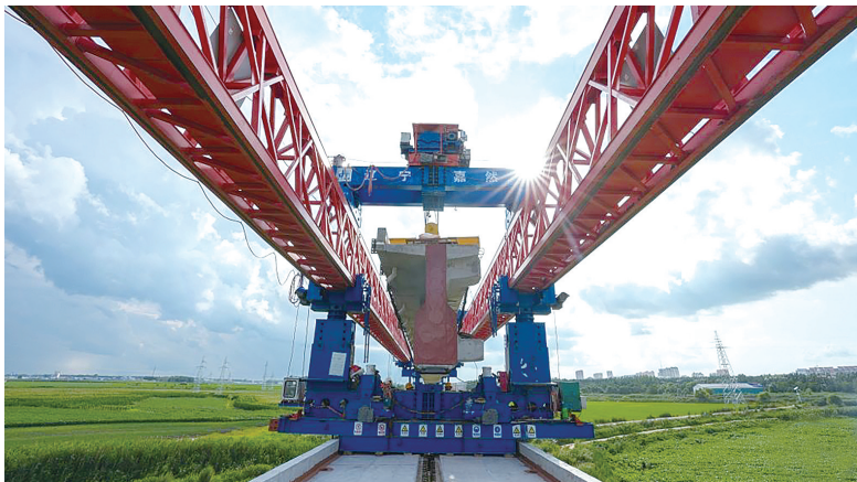
7月25日,中欧班列“东通道”佳同铁路正线施工全部完成,将进入铺轨阶段,我国中欧班列通道建设再提速。 新华社记者/王松 摄
