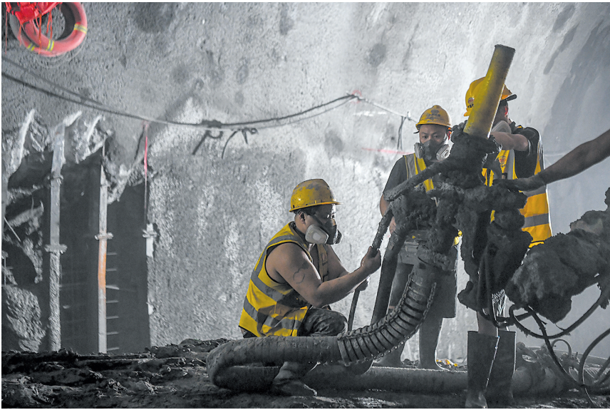
7月24日,工人在渝厦高铁重庆菜园坝长江铁路隧道建设现场施工作业。 新华社记者 唐奕 摄
