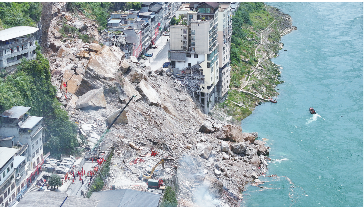
这是7月17日拍摄的重庆彭山水体垮塌现场(无人机照片)。新华社记者/王全超 摄
