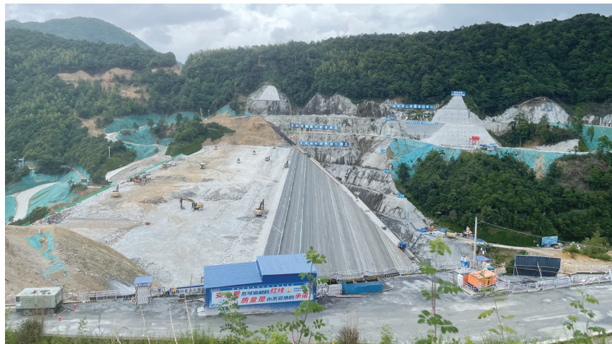
上水库工程建设现场。黎世伟 摄
