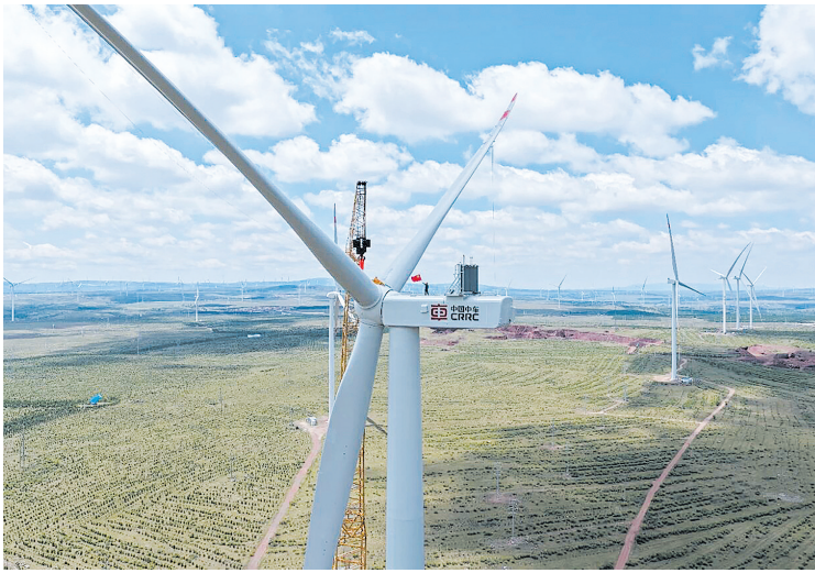
首台样机成功吊装,企业供图
