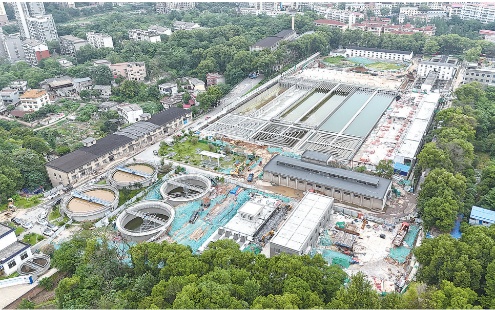
提质扩容改造中的三水厂。记者/张威 摄
