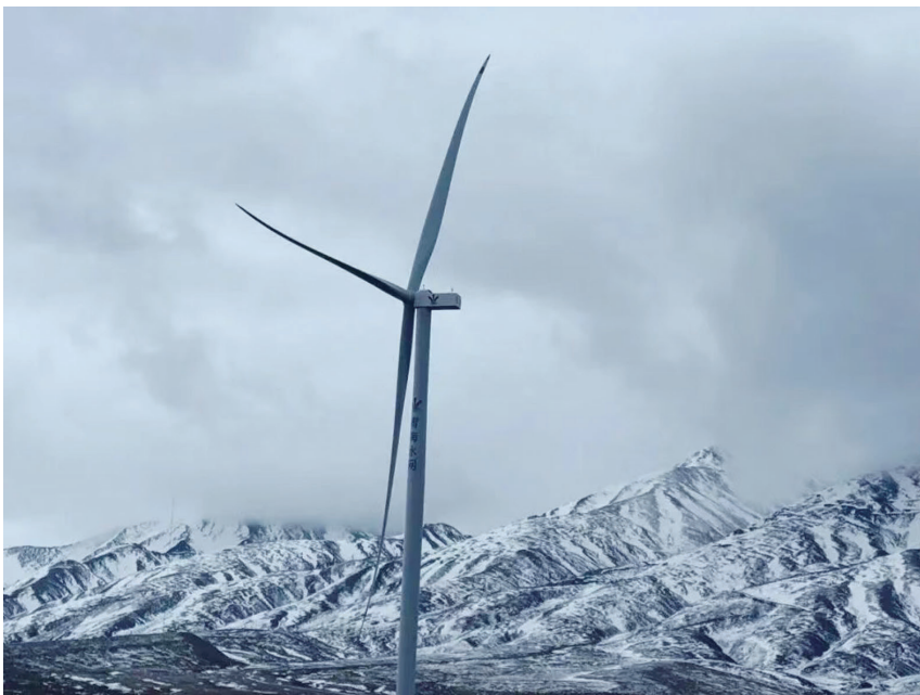
海西都兰400MW风电项目首批机组成功吊装。企业供图
