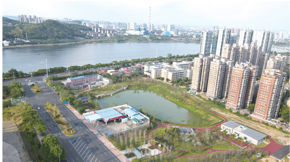
改造完成后的陈埠港小游园。记者/张威 摄
