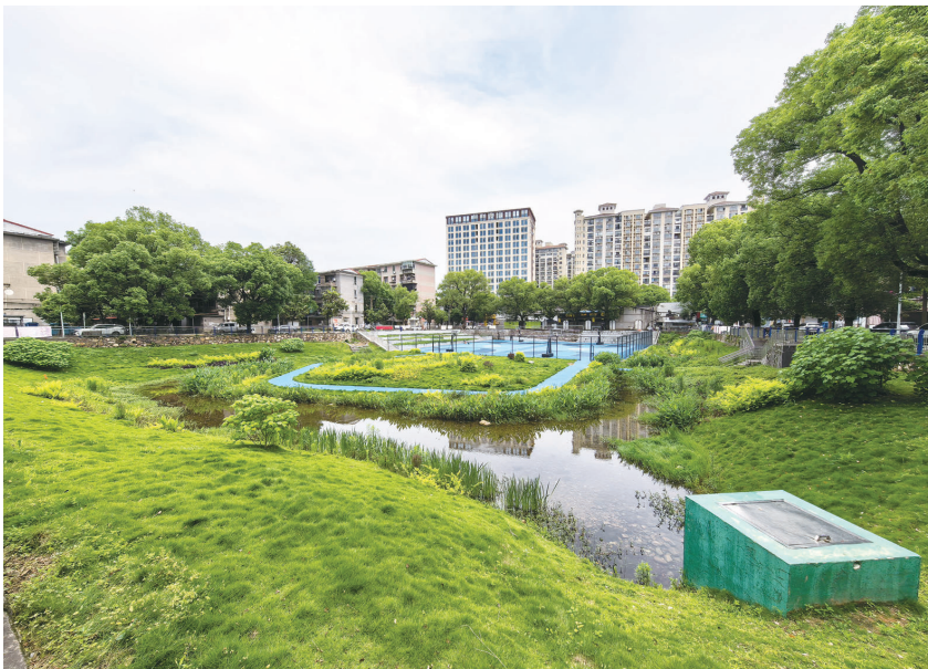
棉纺厂小区下沉雨水广场。记者/张威 摄
