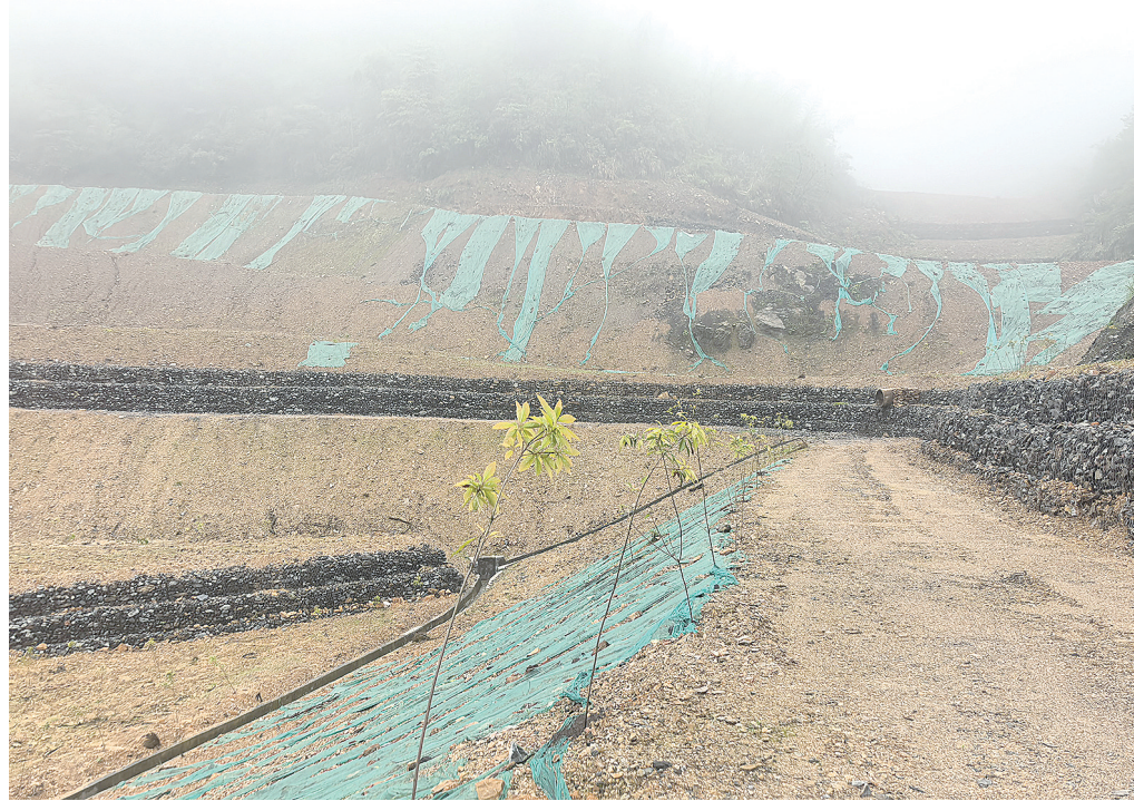
进行修复后的满江村矿区现场。易蓉/摄
