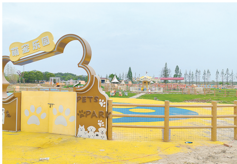
杨梅洲上,正在建设中的萌宠乐园。记者肖星平摄
