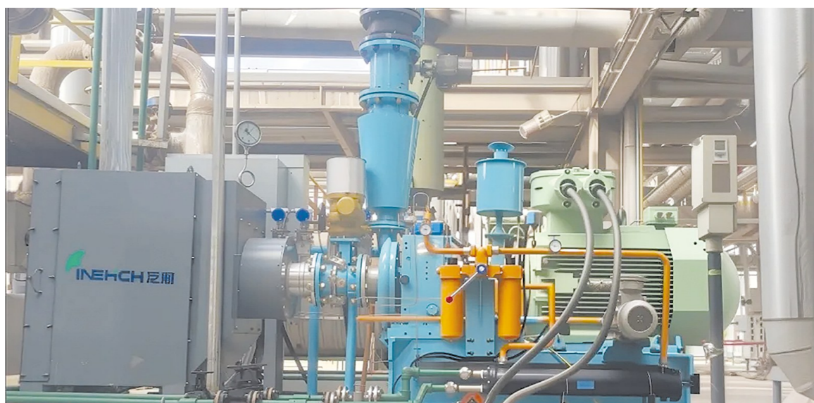
泛航智能HGB130-1.9型超音速离心鼓风机。 通讯员 供图
