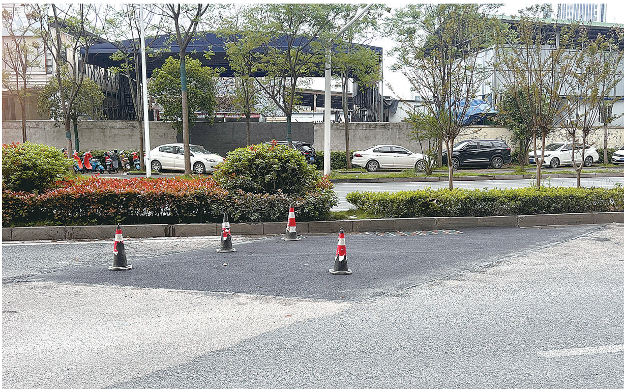
服饰大道坑洼修缮完毕。记者/伍婧雯 摄
