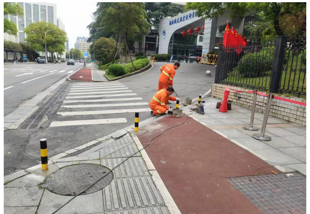
施工现场。通讯员 供图
