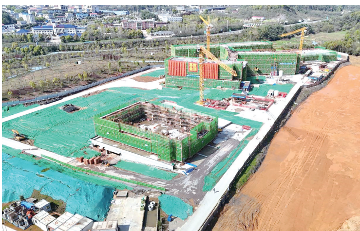
湖南师范大学附属荷塘区高新学校建设项目(一期)封顶。通讯员 供图
