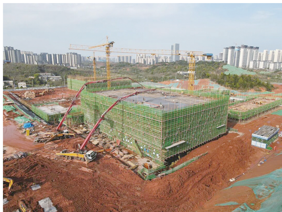
株洲市二中南校区5号楼主体封顶,通讯员供图
