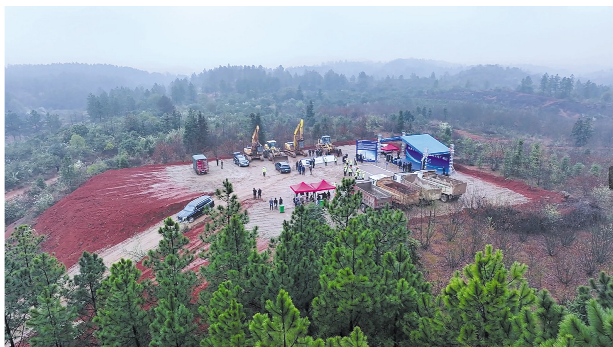
开工仪式现场。通讯员/谭斌斌 摄
