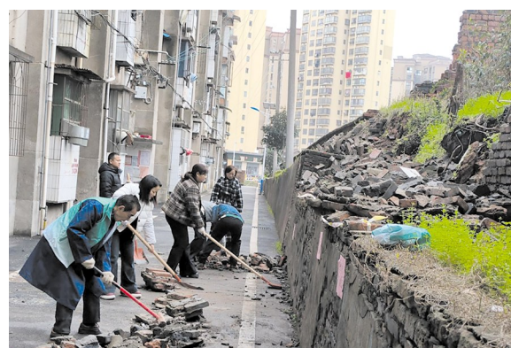
3月5日,志愿者和社区工作人员清理围墙倒塌后产生的砖块、碎石。受访者供图
