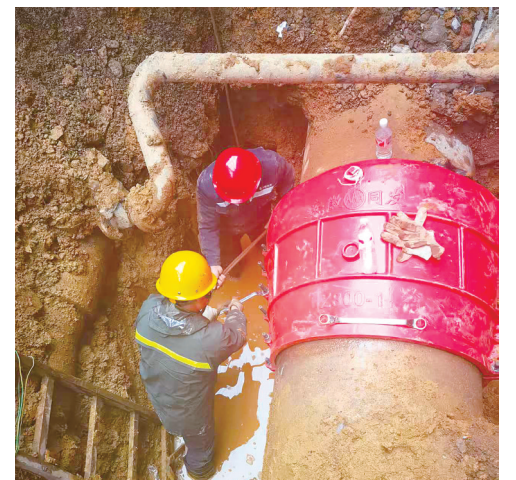
抢修人员采用哈夫节快速止水。通讯员供图
