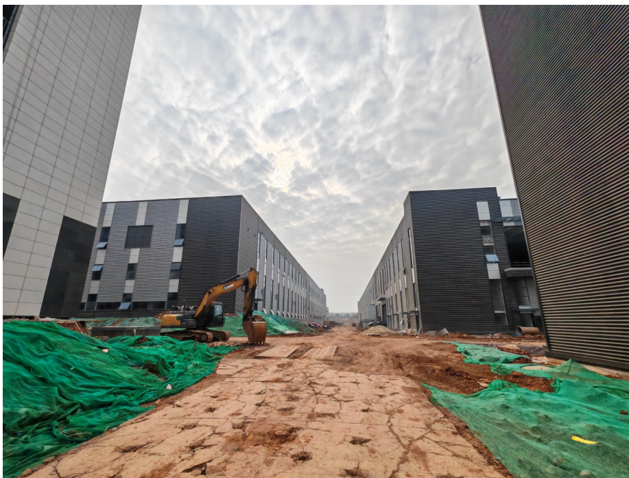
光启技术株洲905基地项目现场。受访者 提供
