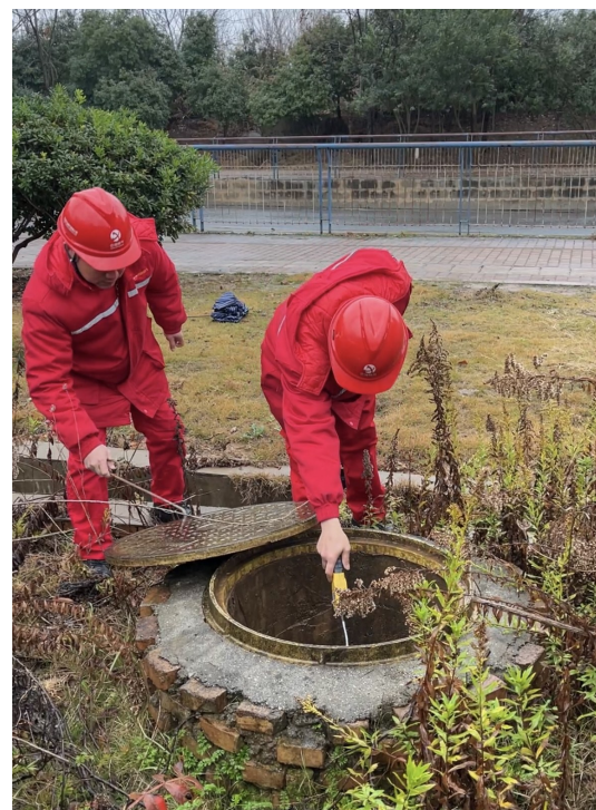
燃气巡检员对户外燃气设施进行检查。 记者/刘平 摄
