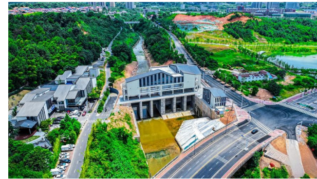
▲枫溪港“最美水闸”
