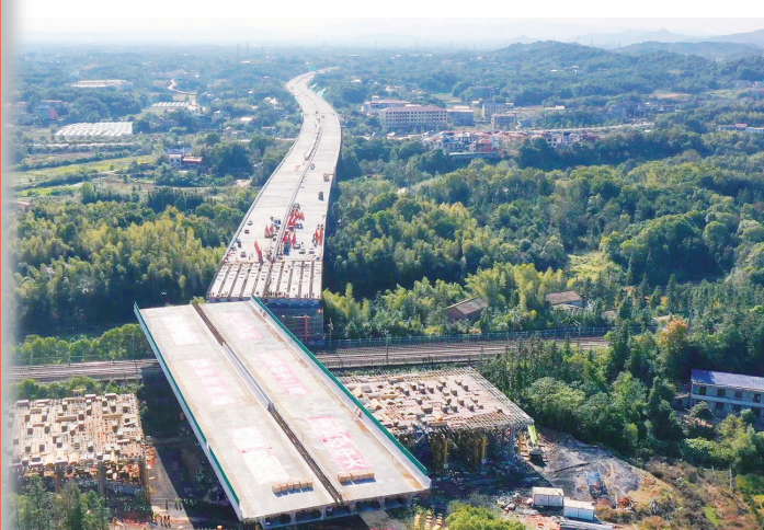
2.3万吨“巨无霸”空中转体。11月27日,醴娄高速上跨沪昆铁路桥完成架设。
