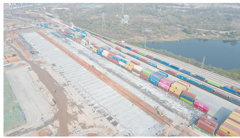
全速推进中的株洲铁路综合物流基地建设项目。记者/张威 摄
