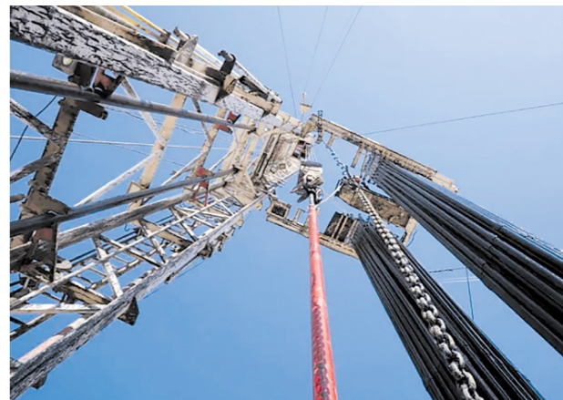
机组已顺利运行一月有余。通讯员 供图
