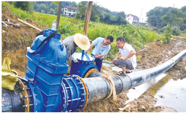
工作人员在铺设自来水管。受访者供图
