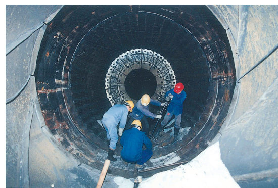
工人们正在进行清理工作。
