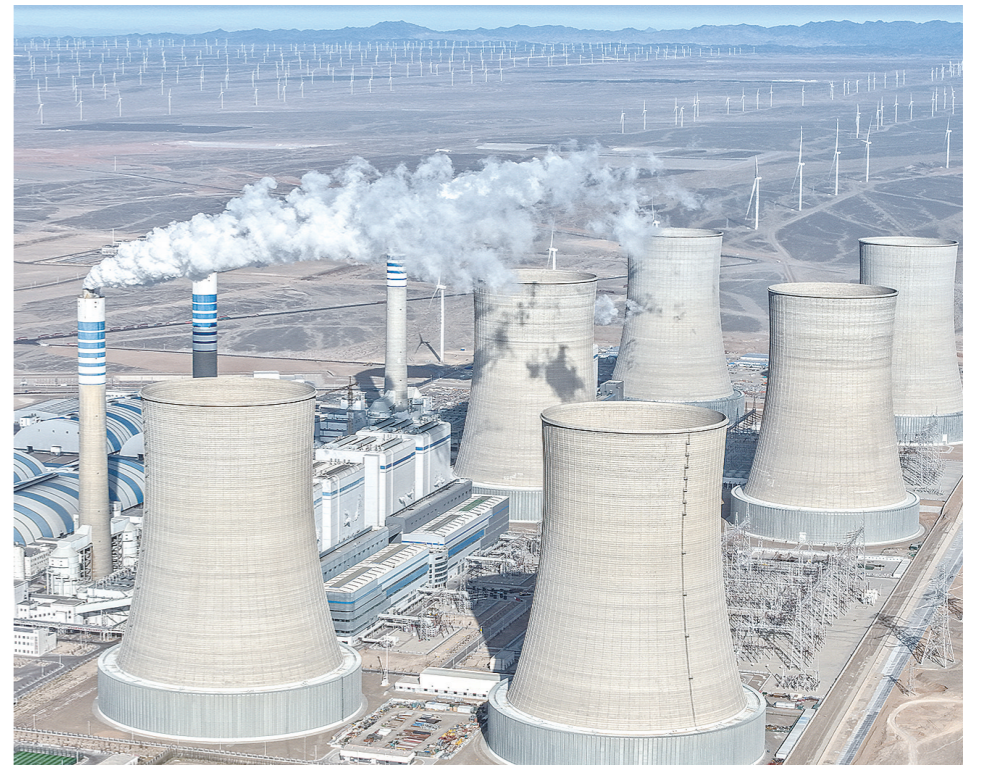
这是11月19日在甘肃省酒泉市瓜州县拍摄的甘肃电投常乐电厂外景(无人机照片)。 近日,随着寒潮来袭,位于甘肃省酒泉市瓜州县的甘肃电投常乐电厂,按照迎峰度冬保电方案,火电机组全力运行,保障冬季电力稳定供应。 甘肃电投常乐电厂是国家西部大开发重点能源建设项目,共有6台100万千瓦火电机组,年发电量可达330亿千瓦时。 新华社记者 郎兵兵 摄
