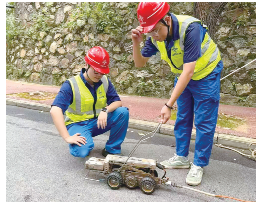
施工人员运用仪器对管道进行探测。通讯员供图
