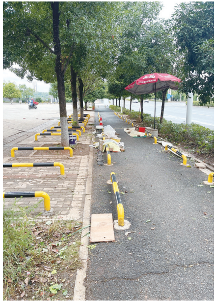
人行道、非机动车道被安装隔离杆。
