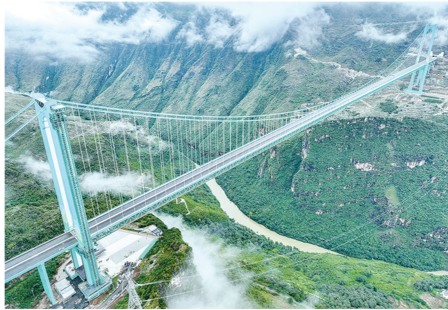
9月26日,雨后的贵州花江大峡谷云雾缭绕,花江峡谷大桥如同“钢铁巨龙”腾跃峡谷之上。花江峡谷大桥是贵州六枝至安龙高速公路的控制性工程,大桥全长2890米,主跨径1420米,是目前世界山区峡谷第一大跨度钢桁梁悬索桥;其桥面距水面垂直高度625米,是新的世界第一高桥。经过三年多建设,贵州花江峡谷大桥将于9月28日正式建成通车。 新华社记者 欧东衢 摄
