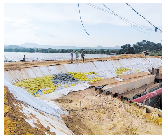
广东省水利厅专家组检查阳江市阳西县文笔岭水闸。 新华社发
