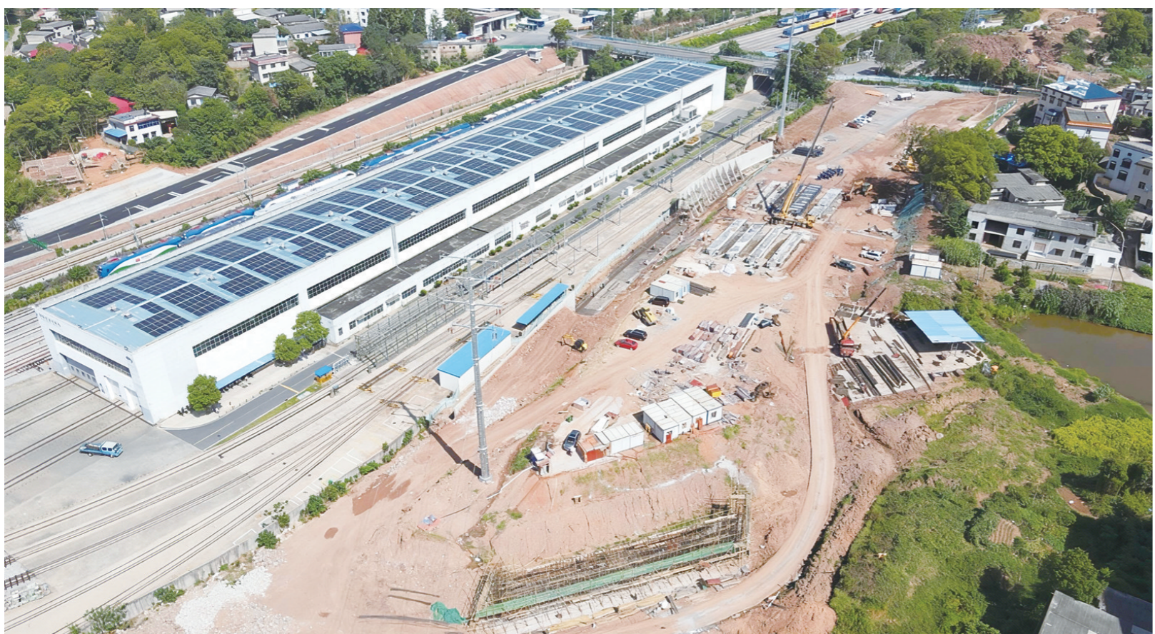
8月31日，石峰区中车大道一期施工现场热火朝天，目前正在全力推进沿线混凝土挡土墙施工，而一墙之隔的正是中车株机高压试验线，另外一边的路基上整齐摆放着8片预制箱梁，这些零件也将马上投用到后期的桥梁建设中，预计今年9月中旬中车大道一期项目将完成桥梁节点的建设。 株洲日报全媒体记者/张威 摄
