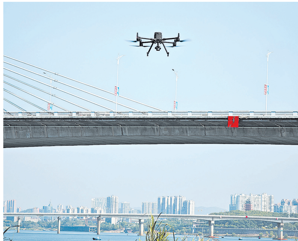
无人机在巡检天元大桥。记者/肖星平 摄
