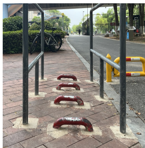
无障碍通道上设有金属条状物,防止电动车、摩托车通行。 记者/刘平 摄
