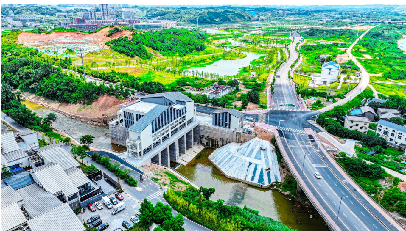
8月6日,航拍重建的枫溪港水闸。记者/杨凌凌 摄
