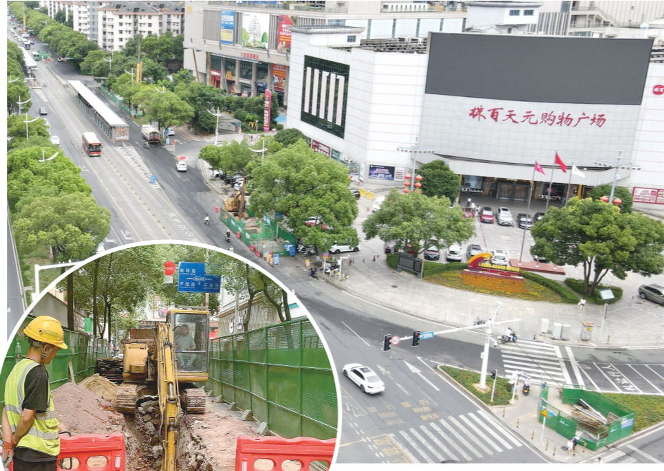
长江南路上下水管网改造项目 记者/张威 摄(资料图)
