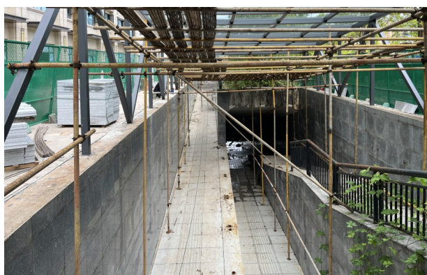
位于向阳北路的地下通道正在 进行改造。 记者刘平摄
