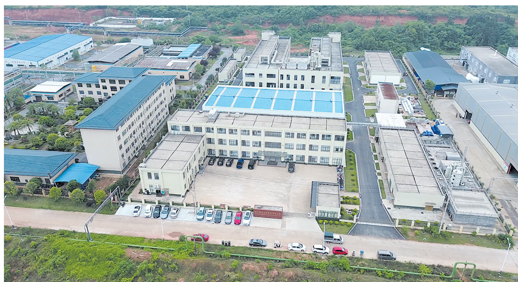
拔地而起的二期项目 通讯员/供图
