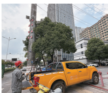
清除高压线异物，通讯员 供图
