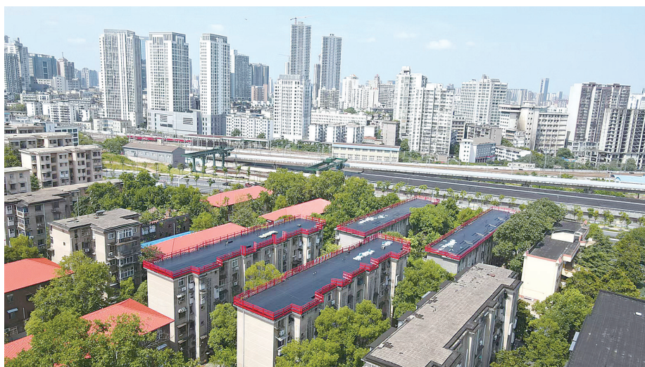
屋顶进行防水作业。
