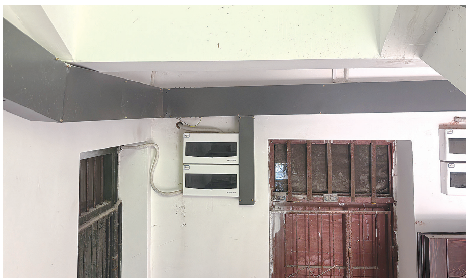
随意悬挂的电线被统一整理,安装线路桥架。易蓉/摄
