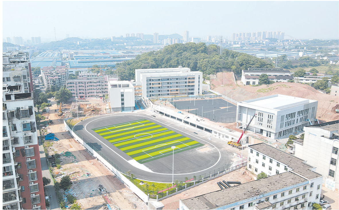
正在建设中的田心中学。记者/张威 摄
