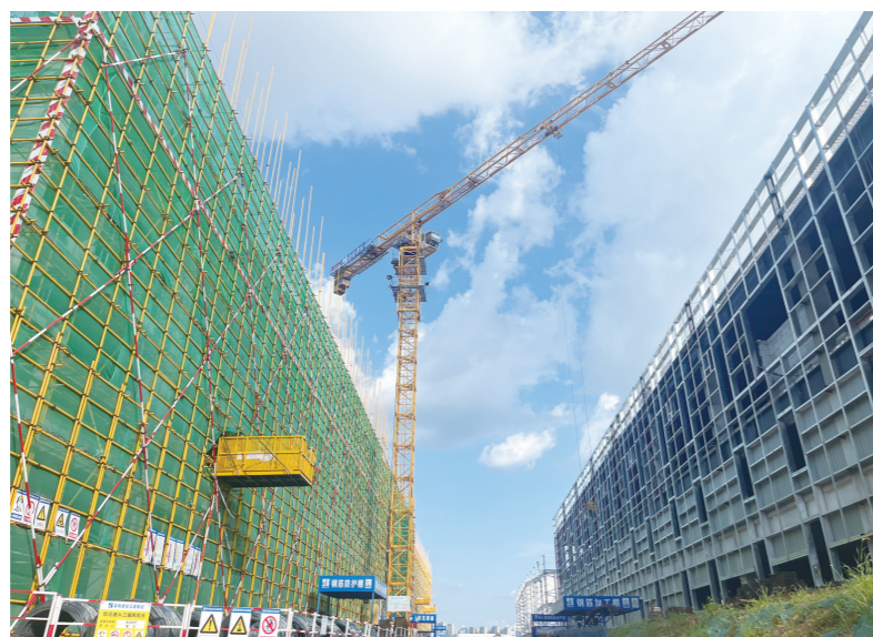
烈日炙烤下,株洲905基地项目正在加快建设。记者/潘东晓 摄
